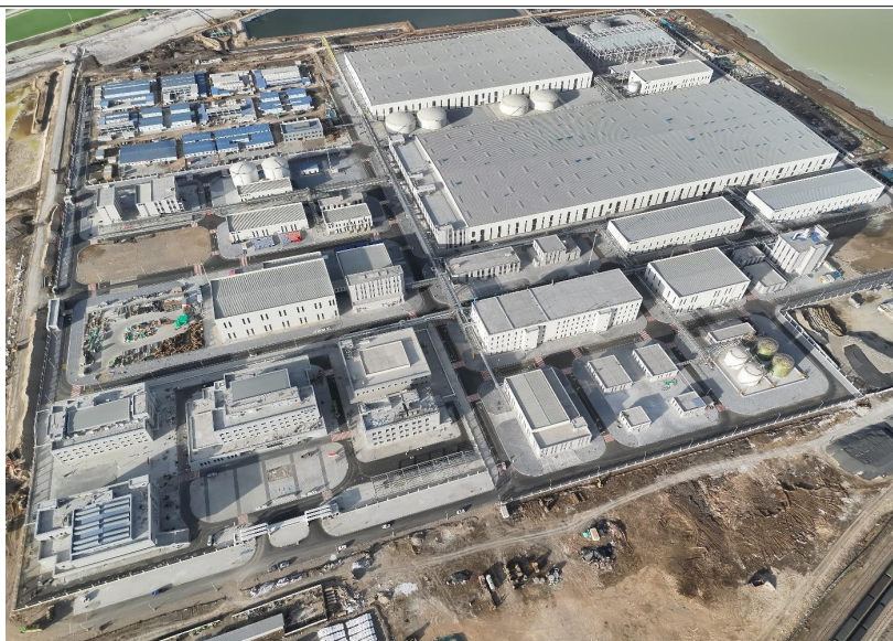
图5：公司4万吨/年基础锂盐一体化项目建设俯瞰图
