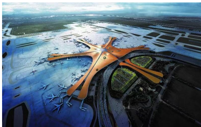
图表72: 耀皮玻璃建筑加工案例项目——北京大兴国际机场
