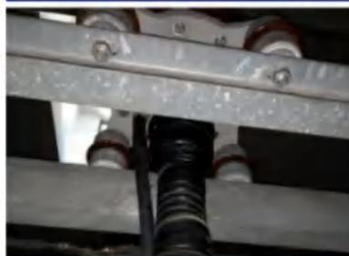
螺栓锈蚀、松动等金具缺陷
