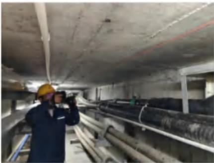
难以对电缆本体开展连续红外扫描，不利于缓冲层烧蚀等随机缺陷的捕捉
