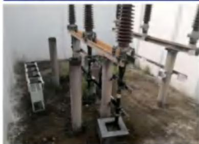
螺栓锈蚀、松动等金具缺陷
