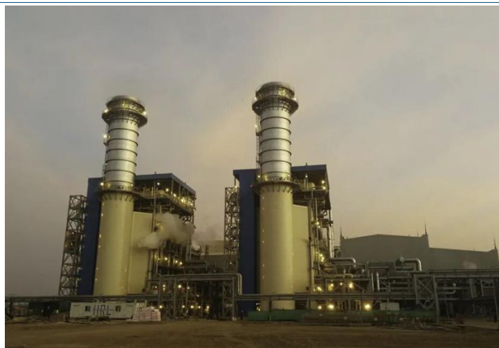
图表86：西子洁能交付巴基斯坦必凯的燃气轮机余热锅炉（配 GE9HA. 01 燃机）
