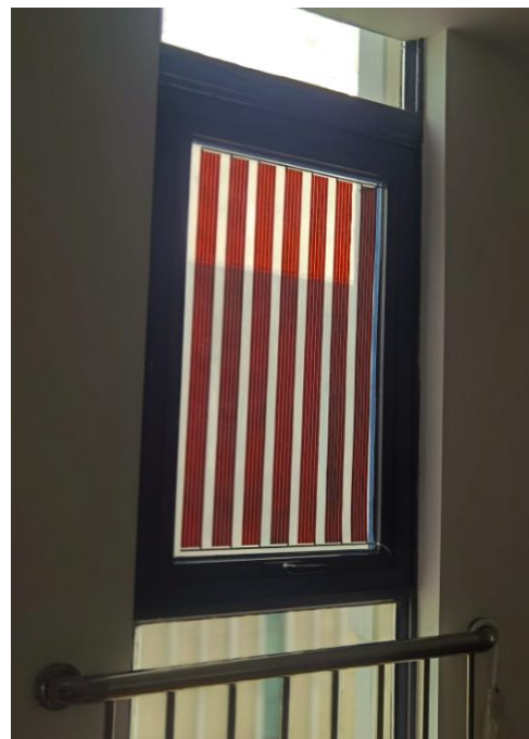
图：单结钙钛矿建筑玻璃BAPV
