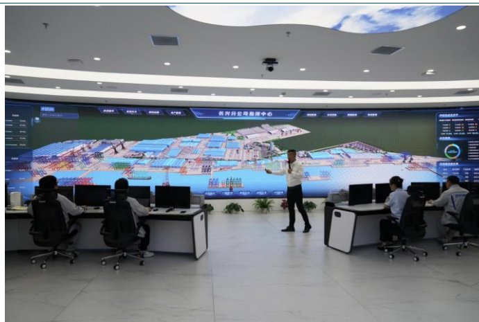
图表25: 公司长兴基地的中控室里, 操作人员可以通过电脑远程操控岸桥工作
