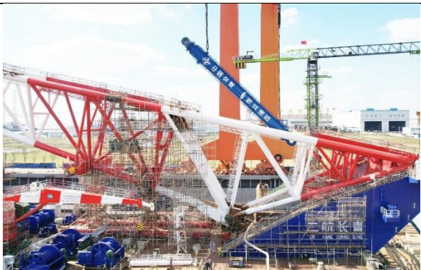
图 25：公司生产的全球最大打桩船液压油缸
