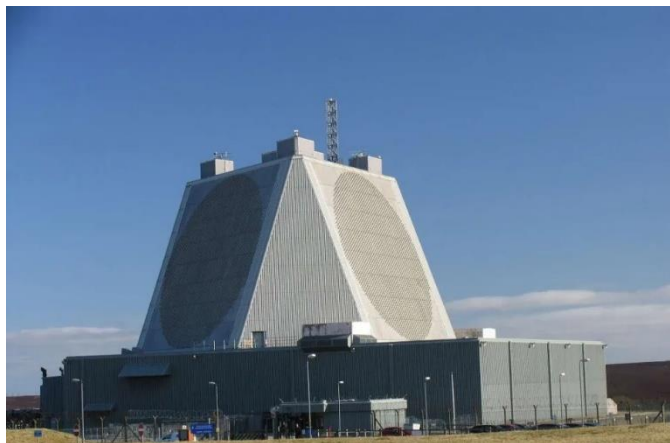
图表13：双面阵的铺路爪远程预警雷达
