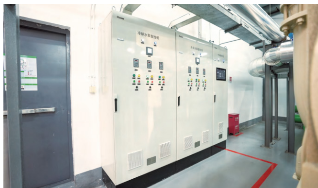
图4-2 海尔楼宇智控管理平台与冷却水泵智控柜
