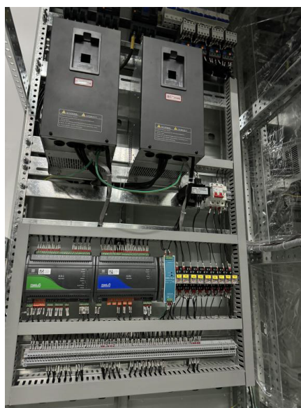
图4-21 IoT-DDC控制箱、传感器
