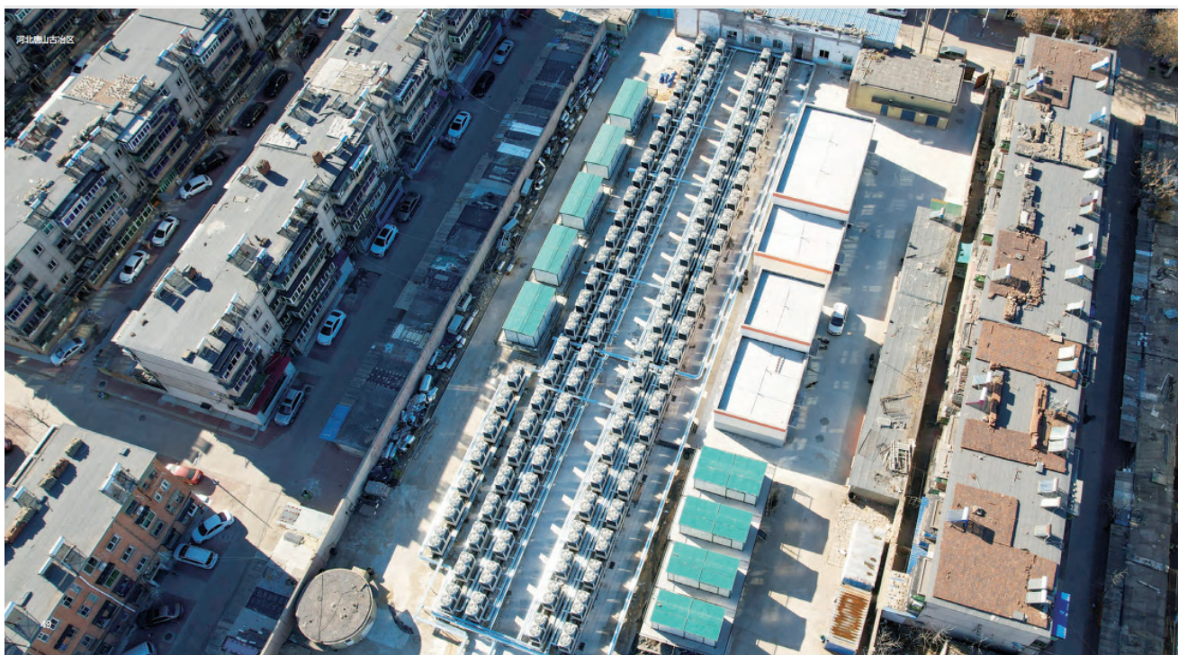
图4-22 河北唐山古冶区智慧供热改造项目
