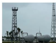
氧排塔、2台120m³ 液氧收集罐
