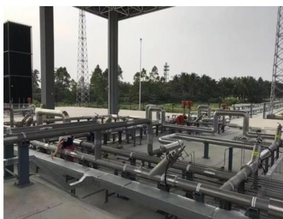
液氢供应系统，发射任务燃料供应的重要动脉
