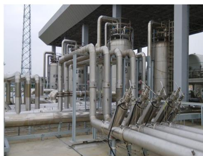
液氧供应系统，发射任务燃料供应的主要动脉
