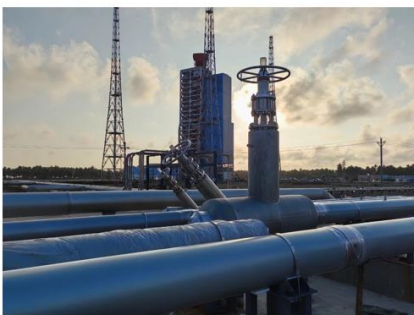
商发液氧供应系统，火箭发射系统的动脉血管
