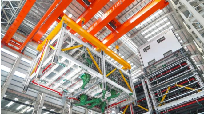
图表22: 巴斯夫抗氧化剂项目模块吊装
