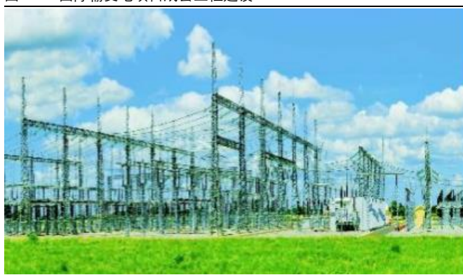
图 10：国际输变电项目成套工程建设
