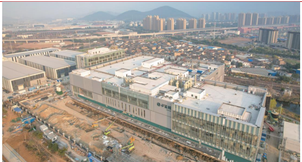
图36: 小菜园马鞍山中央工厂项目即将竣工
