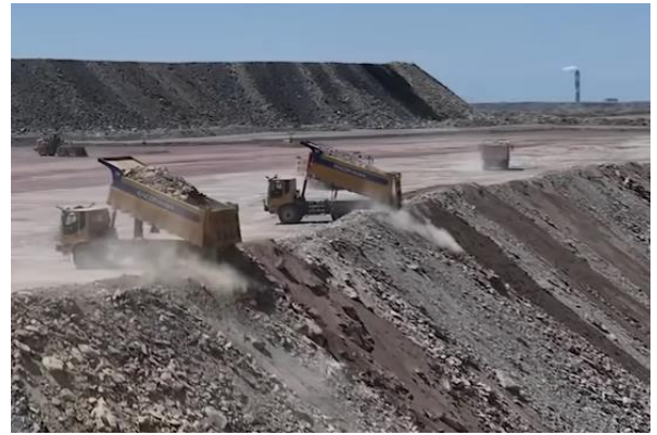
图16: 矿卡停靠挡墙倾倒土方
