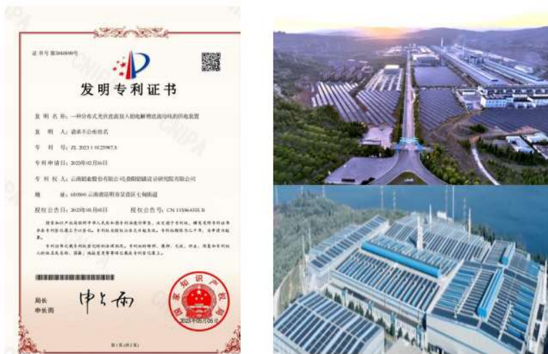
图 43 云铝光伏发电直电接入电解铝生产用电项目
