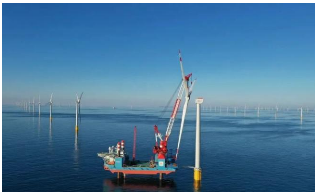
图16: 华能大连庄河海上风电项目
