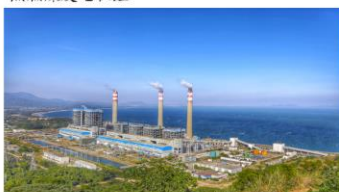
广东华阳西电厂5、6号机组工程 项目内容：首个124万千瓦高效超超临界燃煤发电工程
