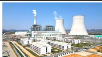
中能建崇左2×660兆瓦电厂工程 项目内容：建设2台660兆瓦超超临界燃煤发电机组
