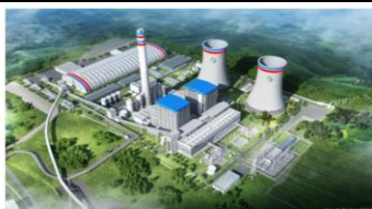
贵州能源普定电厂项目EPC总承包工程 项目内容：两台66万千瓦高效超超临界二次再热燃煤发电机组
