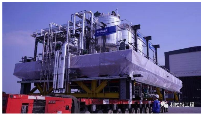
图 13: 巴斯夫全球首个模块化项目模块运输过程
