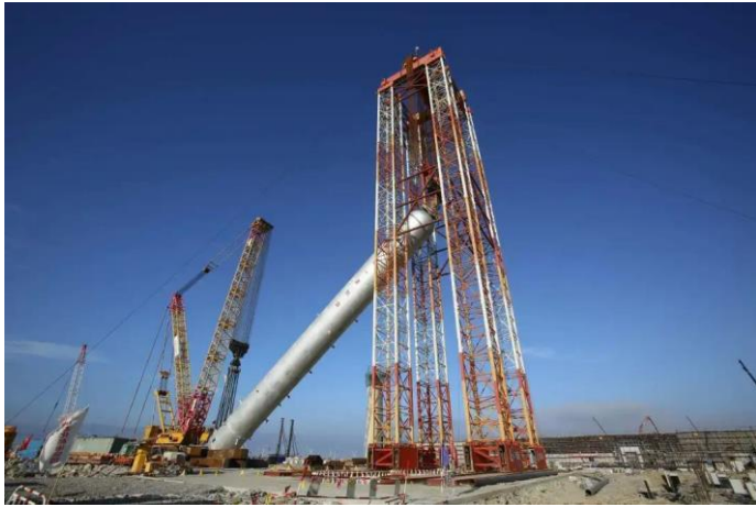
图表12: 浙石化 3000 吨级世界单台重量最大加氢反应器
