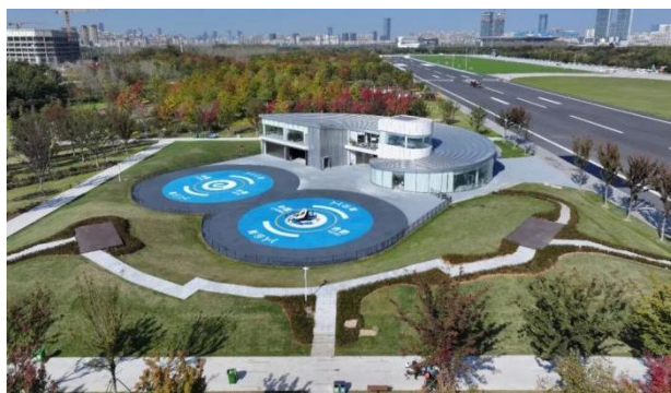
图53: 亿航智能合肥骆岗中央公园城市空中交通枢纽港实景
