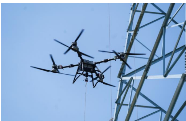
图22: 无人机参与特高压放线作业
