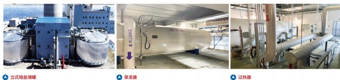
图表56：公司在光热电站领域主要提供吸热、换热、储热系统等核心设备
