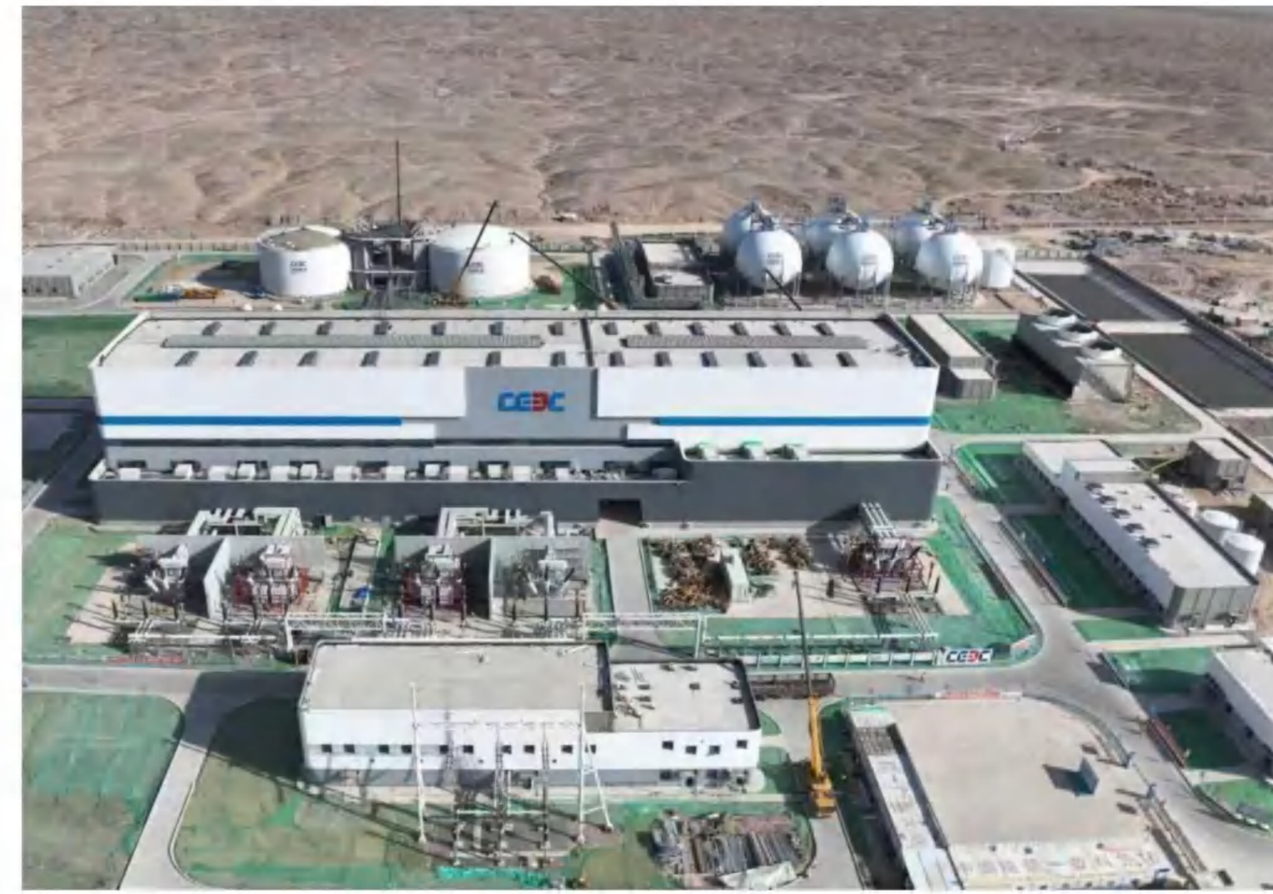
“源储一号” 甘肃酒泉项目
