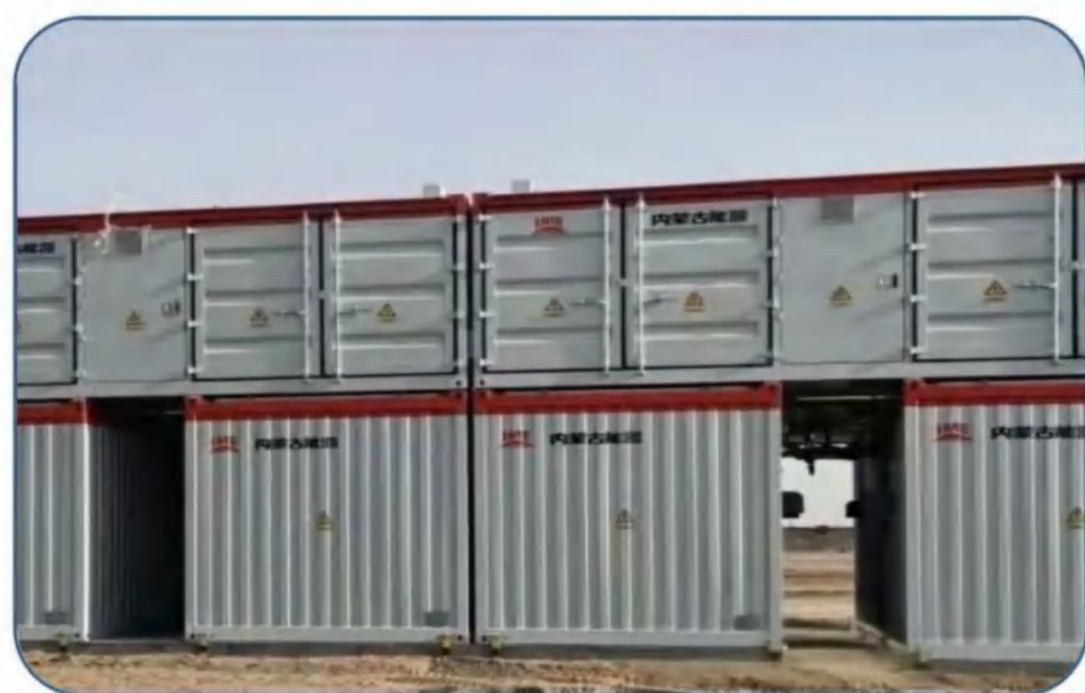
基于 400\text{ mA/cm}^2 高功率密度电堆的 1MW/5MWh全钒液流电池系统
