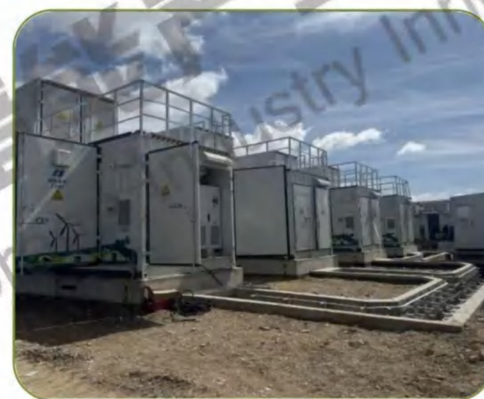
MW级锌溴液流电池储能系统
