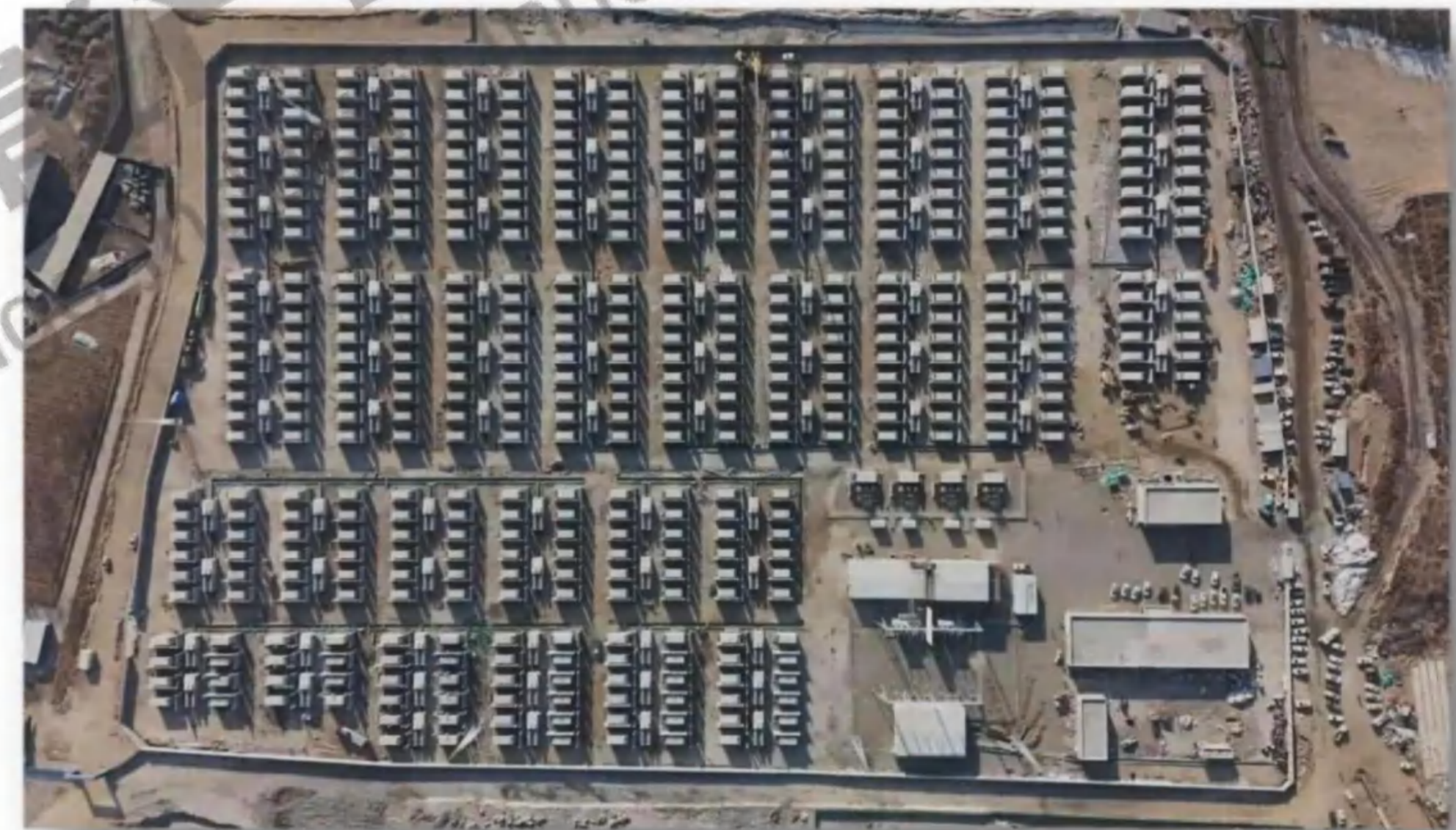
400MW/2.4GWh GWh级储能电站
