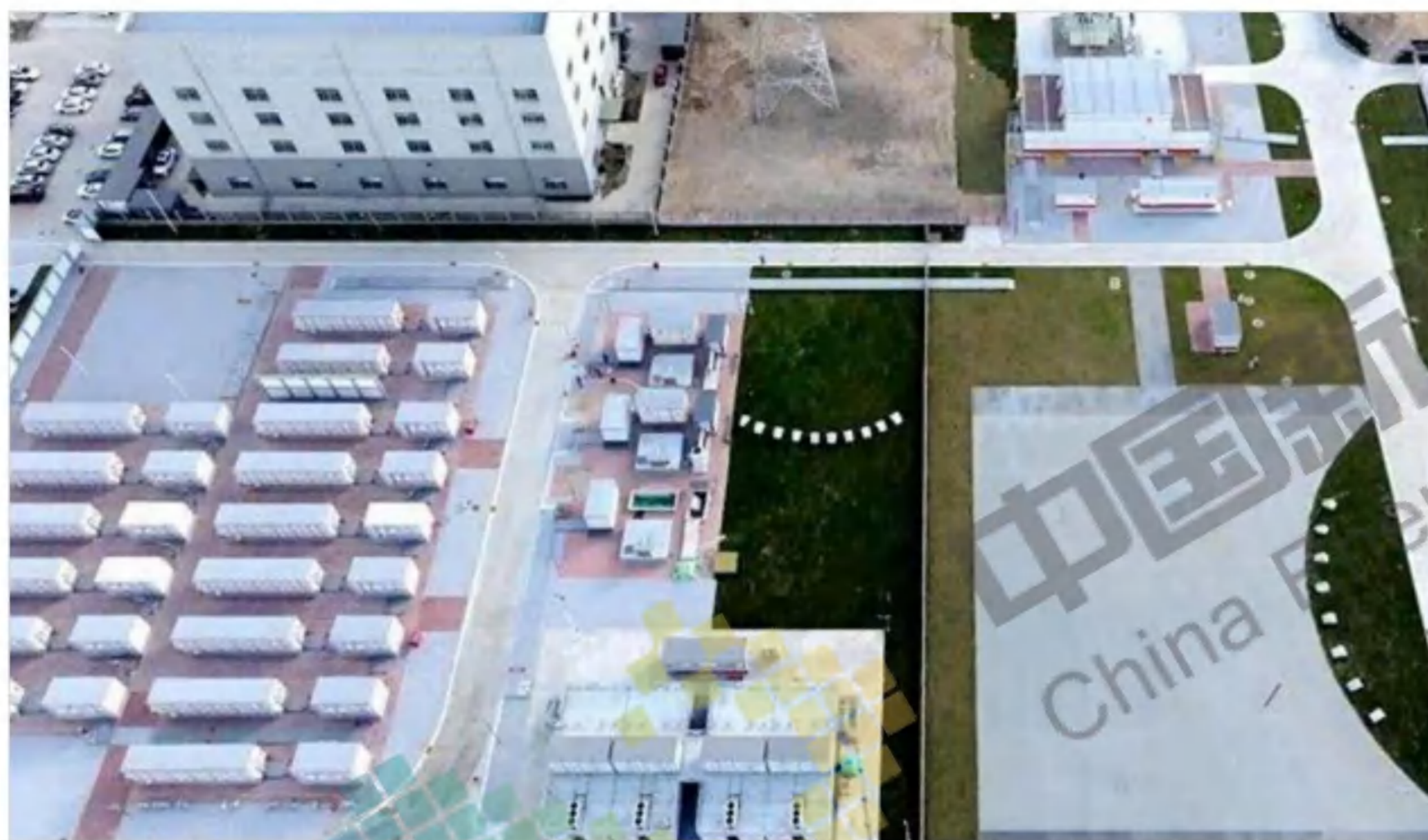
山东蓬莱电厂101MW/205MWh复合储能电站项目
