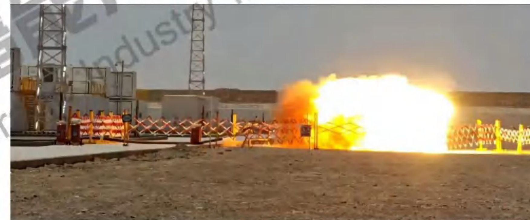
新疆阿克苏乌什250MW/1000MWh储能电站构网型全钒液流储能项目成功通过人工短路试验
