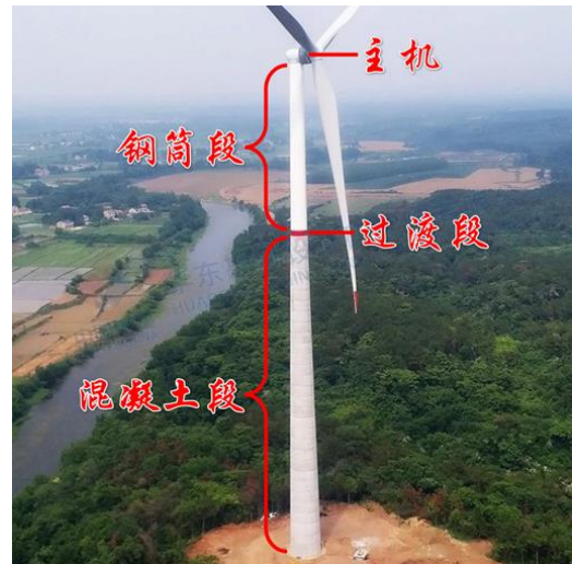
图表31：风电混塔示意图
