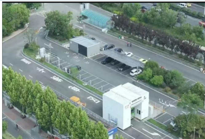
图表23：南京铁心桥服务区光储充重卡换电示范站
