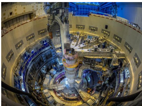
图17: 2026年1月29日 ITER 完成第四个扇区安装
