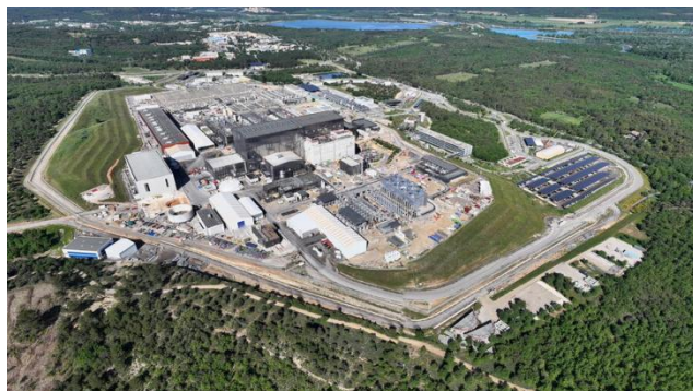
图18: ITER 装置全景
