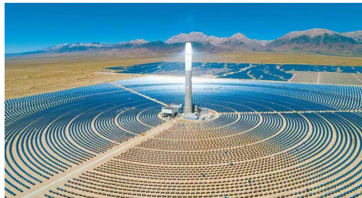
图 21：青海中控德令哈 50 兆瓦光热电站
