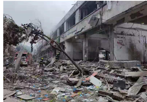
图表：2021年湖北“6·13”十堰燃气爆炸事故现场
