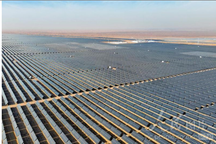
图3: 宁夏中卫 50 万千瓦"源网荷储"光伏项目
