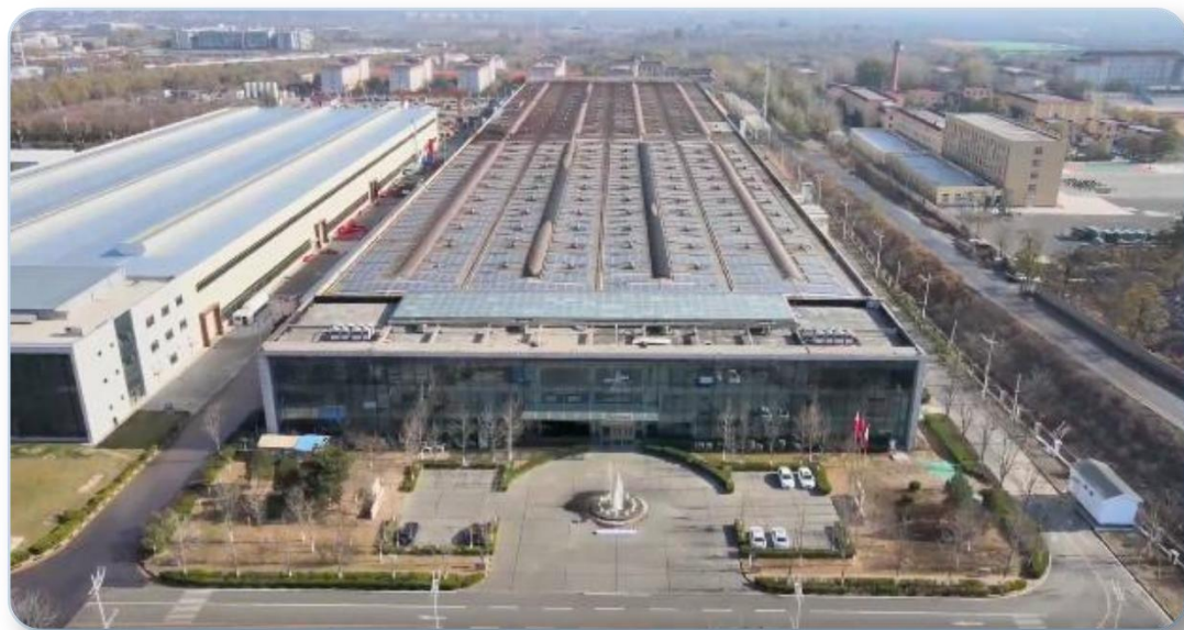
图：三一重工北京桩机工厂（全球重工行业首家“灯塔工厂”）
