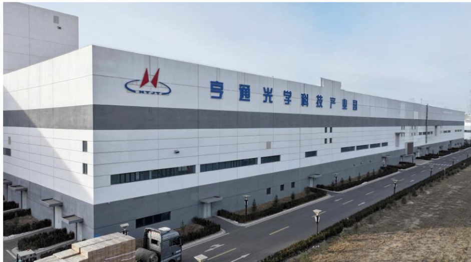
图25：亨通光电内蒙古光纤预制棒生产基地
