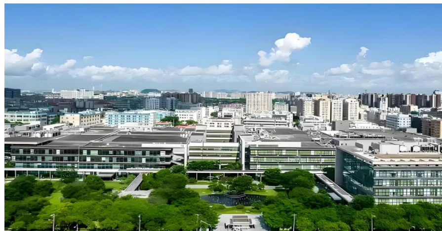
协鑫能科的工业储能项目
