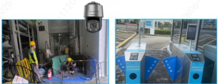
5G摄像头施工现场AI监控
