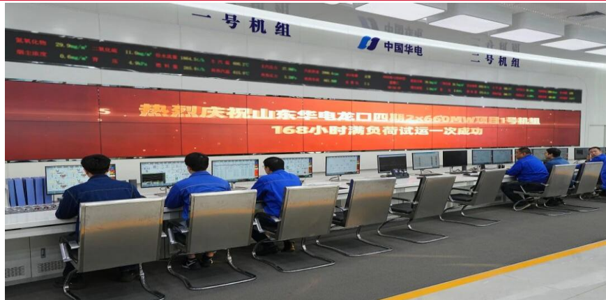
图表52: 华电龙口公司四期 2×66 万千瓦热电联产项目 1 号机组是国内首个π型炉完成 19%THA 深度调峰试验项目
