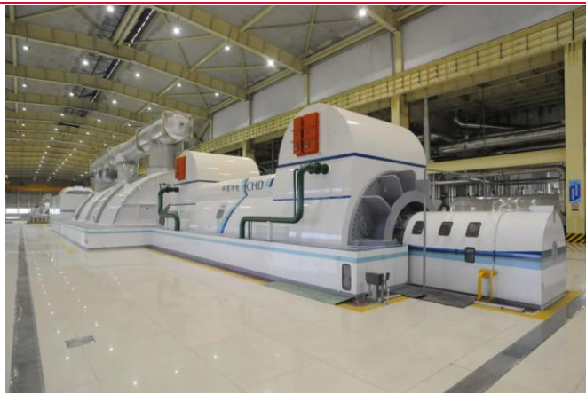
图表48：华电邹县7号机组技改性大修胜利竣工，打造“三改联动”标杆样板
