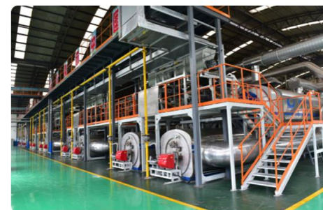
山东项目现场
