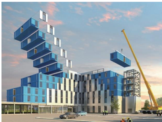
图 41:模块化数据中心乐高式安装
