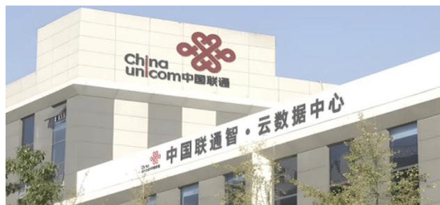
图9: 依米康-中国联通华东云数据中心运维服务项目
