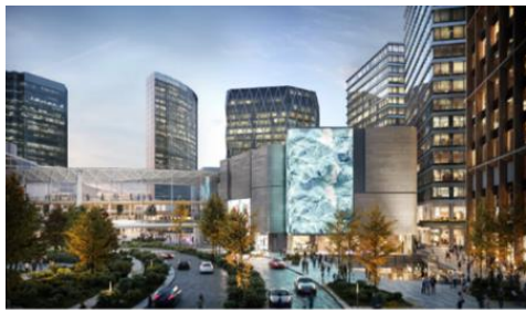
北京太古坊 建面：37.6万方 竣工：2026年底起
