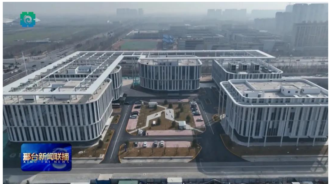
图1：华为（邢台）大数据产业园一期工程
