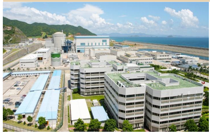
图 7：深圳岭澳核电 100MW 常规岛辅机项目
