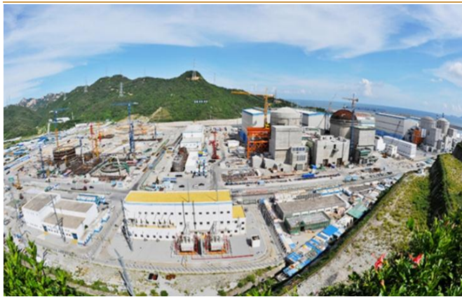
图 6：阳江核电 100MW 常规岛辅机项目
