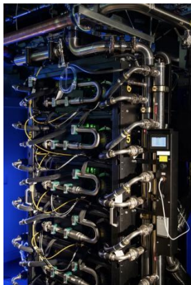
图表 3：TPU 8 系列采用的谷歌第四代液冷架构
