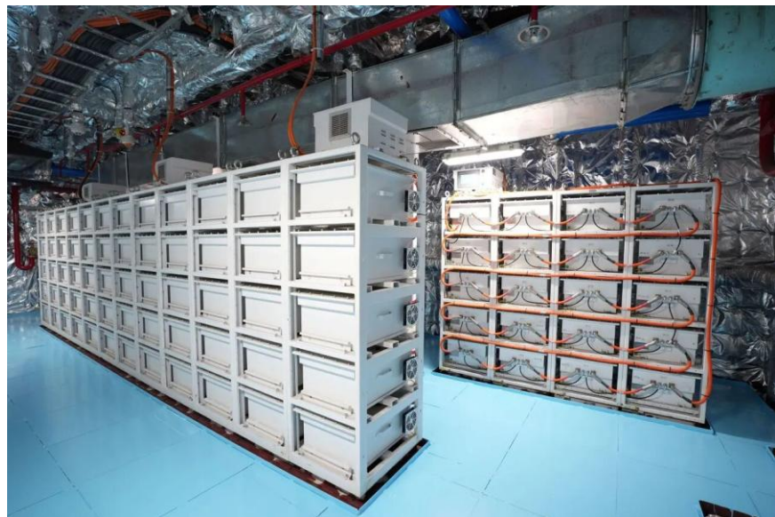
图 16：“长江行·揽月”创新应用“燃油+动力电池”混合动力系统
