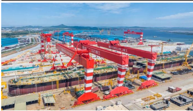
图 29: 恒力重工一期“海洋工厂”船坞
