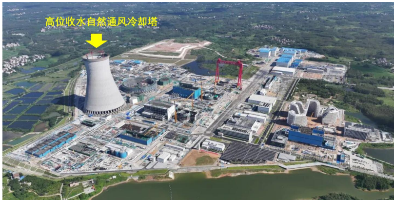
广东廉江核电项目一期高位自然通风冷却塔
