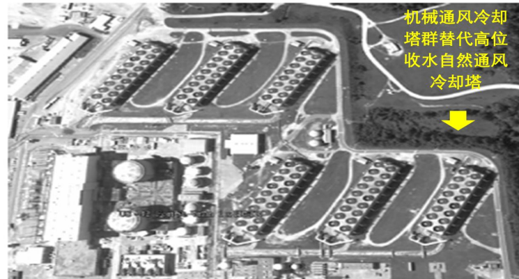
美国圣符伦堡核电厂逆流式机械通风冷却塔群
