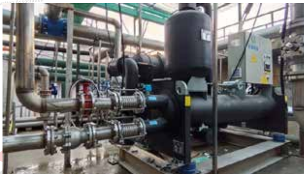
图 5-10 某漂染工厂多级阶梯式余热回收热泵系统现场图
