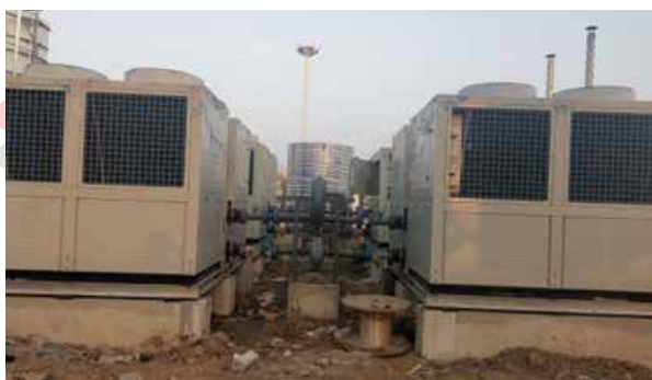
图 5-8 北油田原油加热项目现场图
