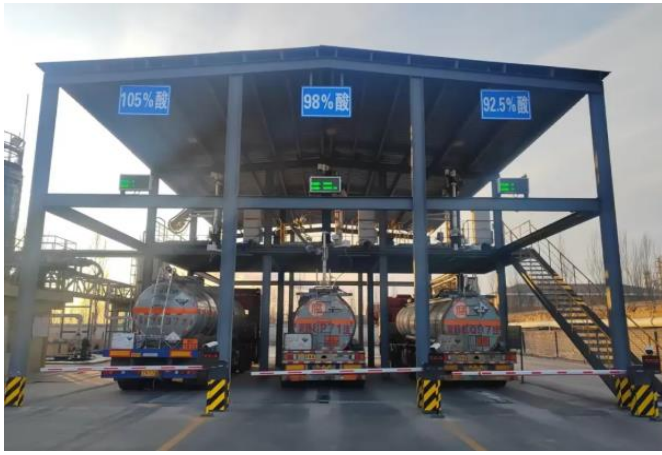
图13: 金辉稀矿硫酸厂全流程自动装酸系统
