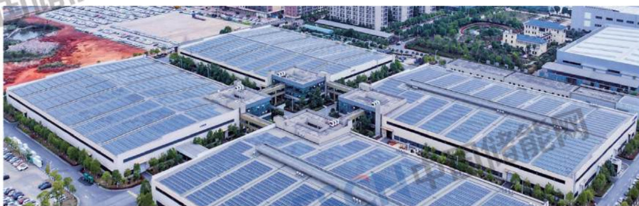
图 8-12 威胜能源汨罗循环经济产业园区智慧绿色微电网
