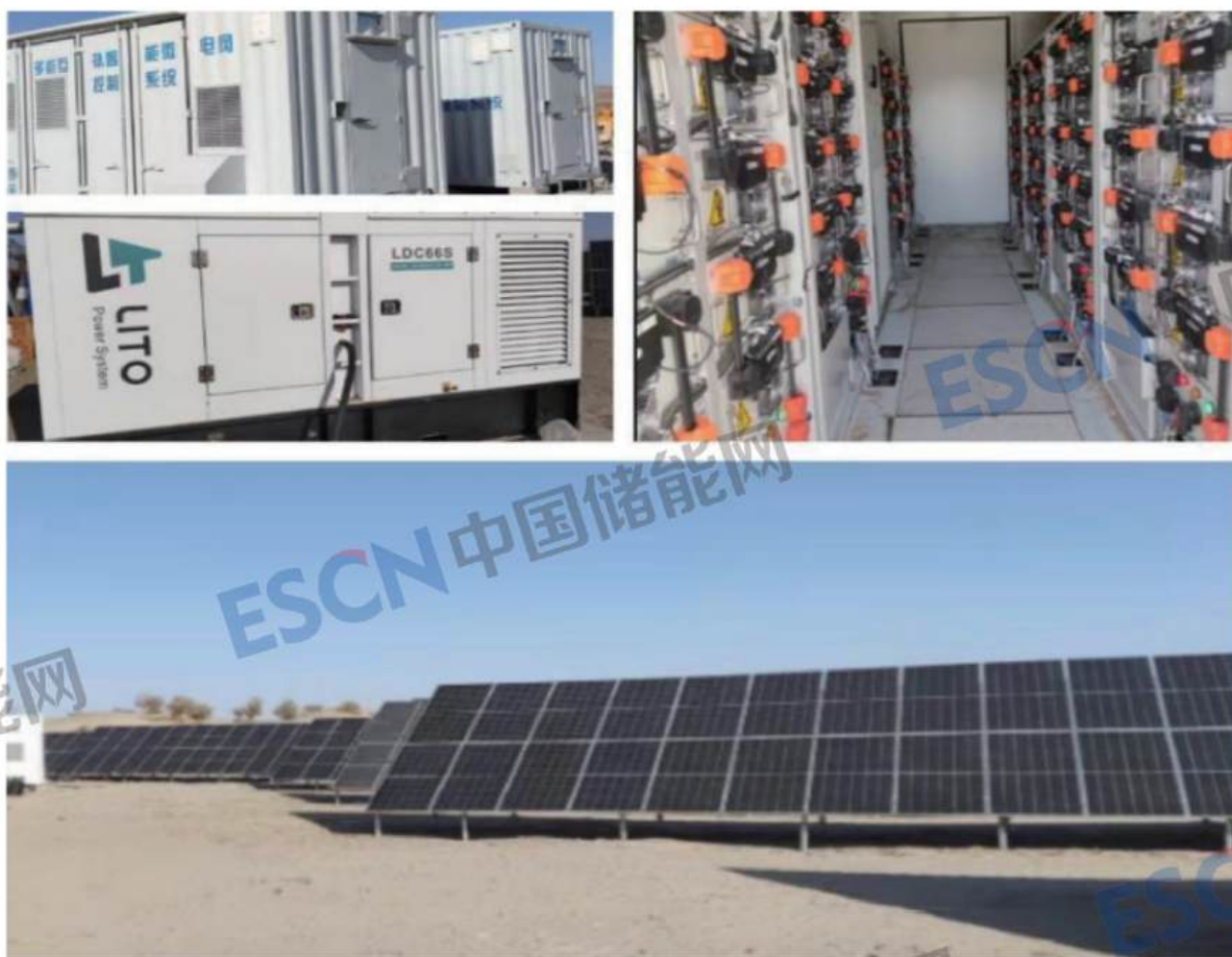
图 8-13 新疆玛东油田 3 号井光储柴微电网系统
