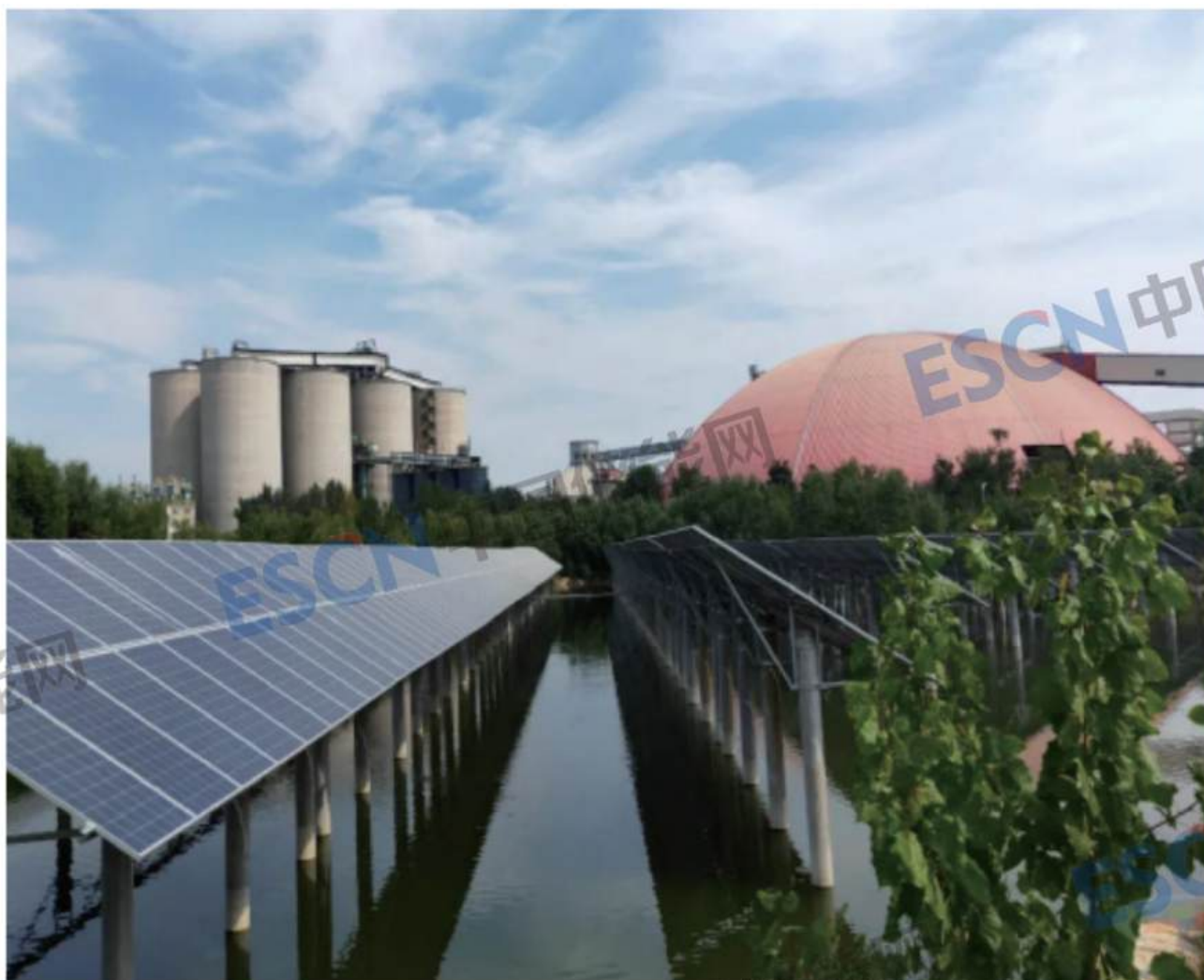
图 8-9 济宁海螺水泥零外购电智慧微网
