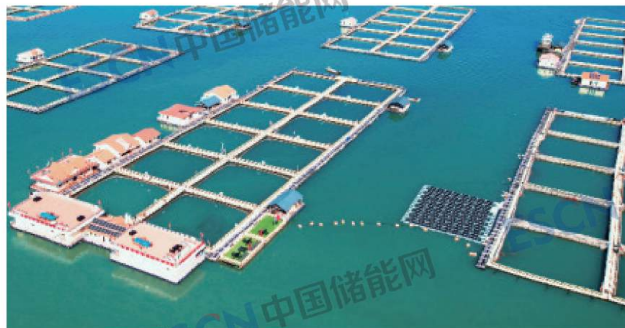
图 8-5 宁德“风、光、储、充、用”微电网示范项目
