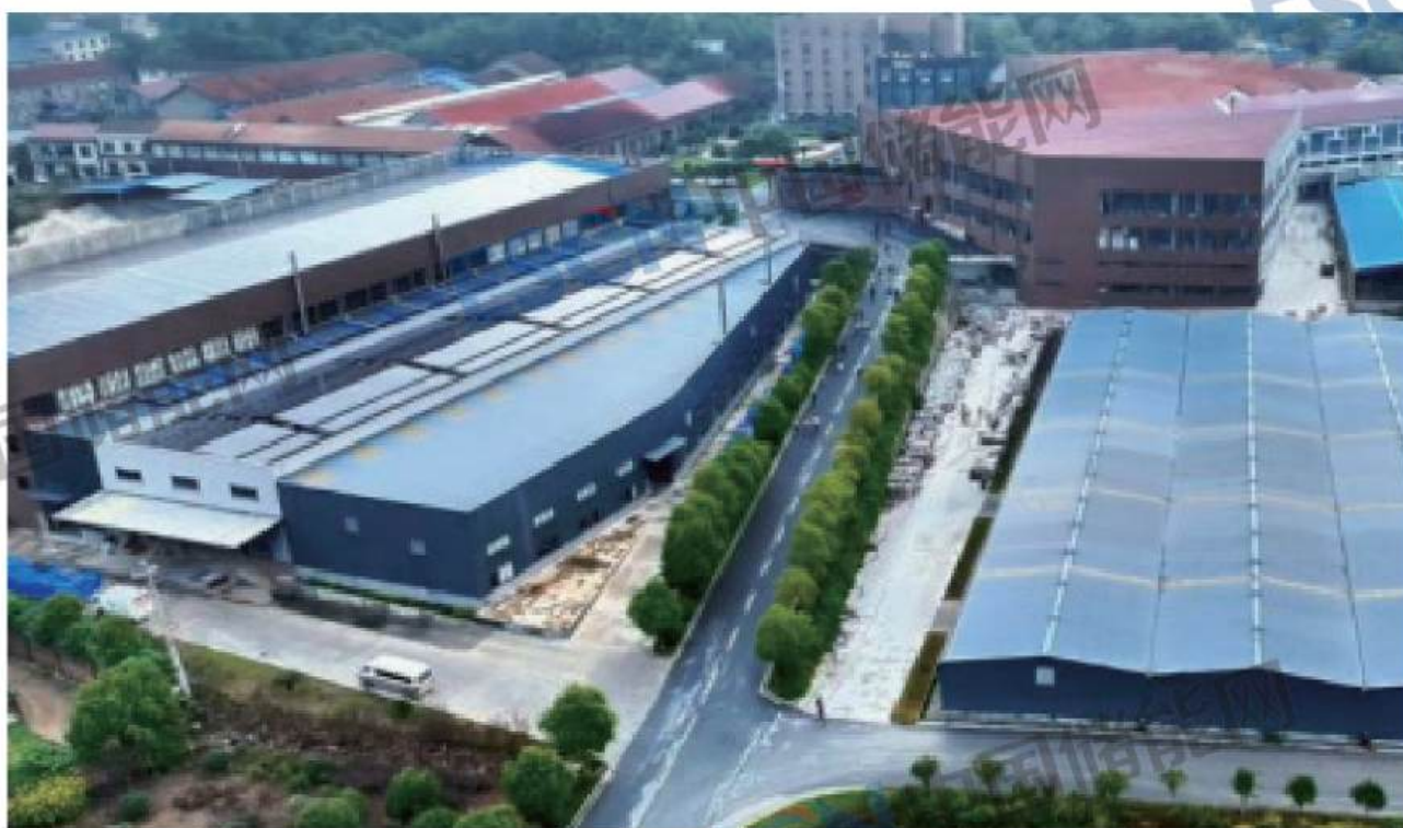
图 8-16 湖南泰鑫瓷业有限公司智慧能源及微电网系统分布式光伏
