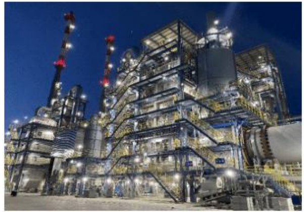
图15: 山东裕龙产业园危废焚烧项目
