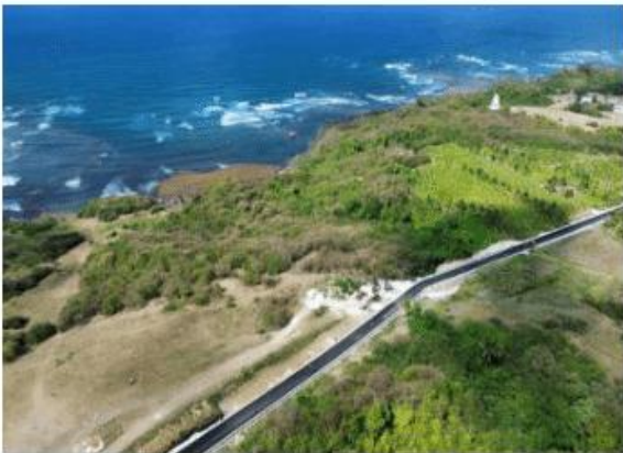
图12: 巴巴多斯苏格兰地区道路修复项目
