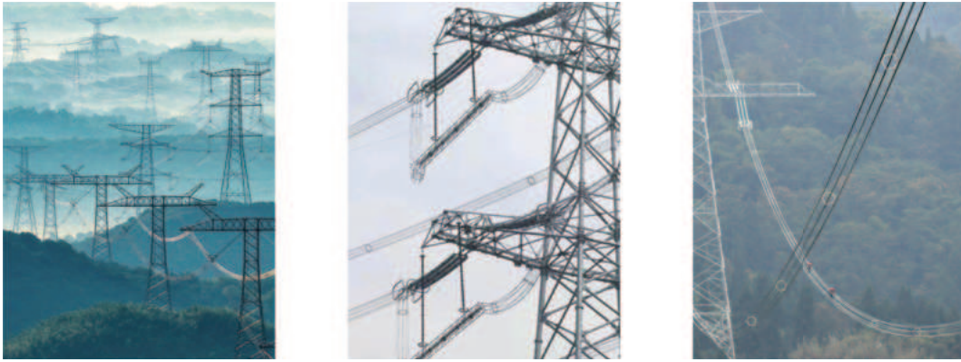
图 3-5 输电架空线路巡视的三类主要场景 - 通道、杆塔、导线
