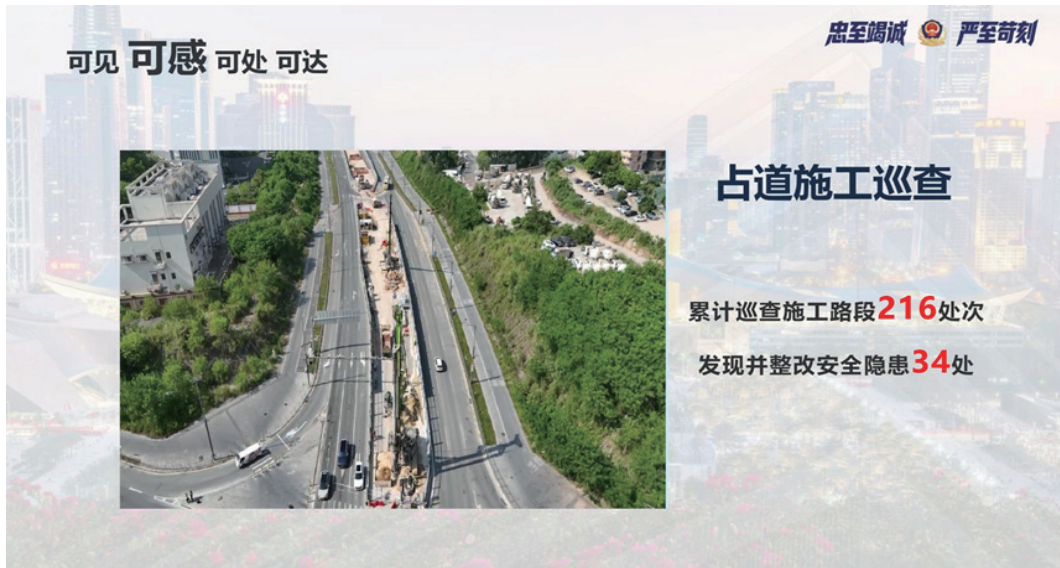
图 3-25 无人机高空鸟瞰城市占道施工路段，实时掌握施工现场安全状况
