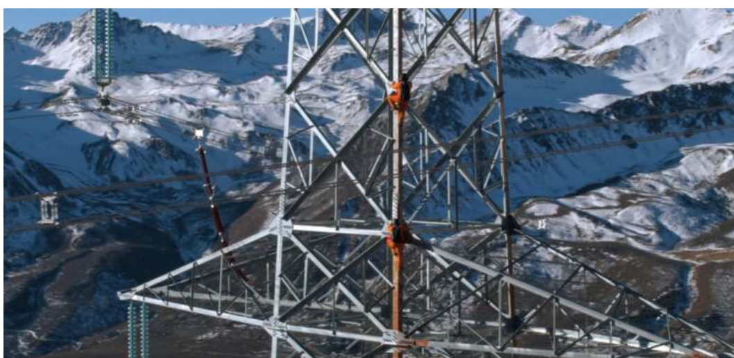
图 3-4 传统的人工巡检已逐渐被更智能的巡检方式替代
