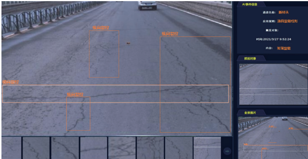
图 3-37 业务平台道路病害检测
