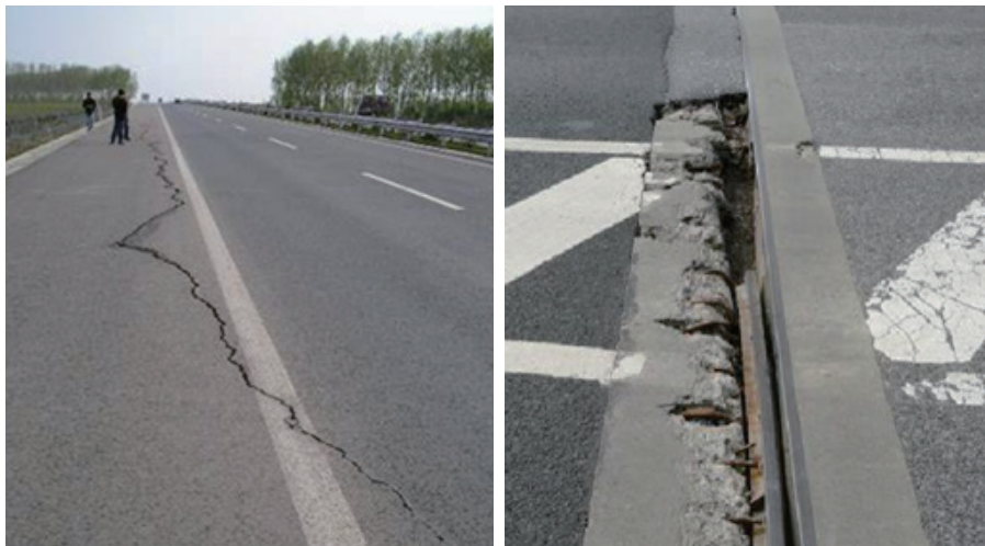
图 3-29 道路裂缝
