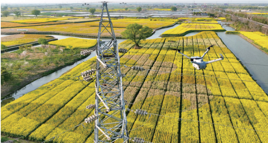
图 3-9 无人机巡检输电杆塔
