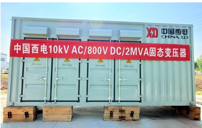
图表26: 中国西电 10 千伏 SST 在光储充系统成功投运
