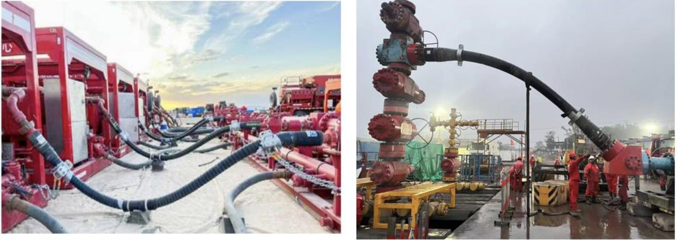
图5：酸化压裂高压软管应用现场
